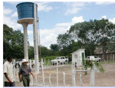
Obra do PCPR
