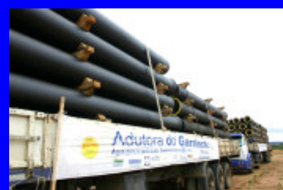
Mais equipamentos para a obra
