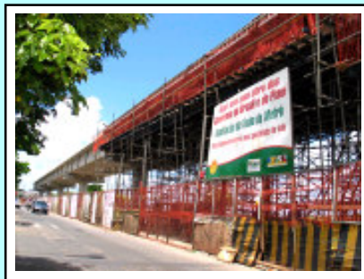
Retomadas as obras do metrô
