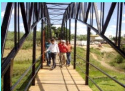
Passarela sobre o rio Piauí
