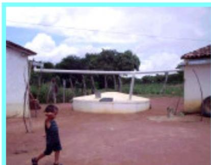
Cisterna de placa usada em captação
