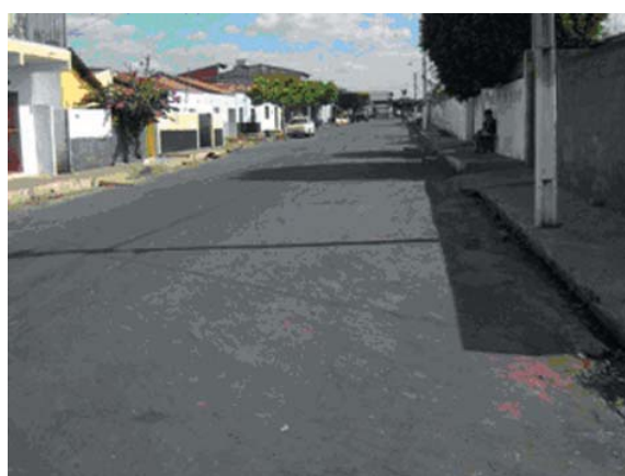
Obra em Bocaína
