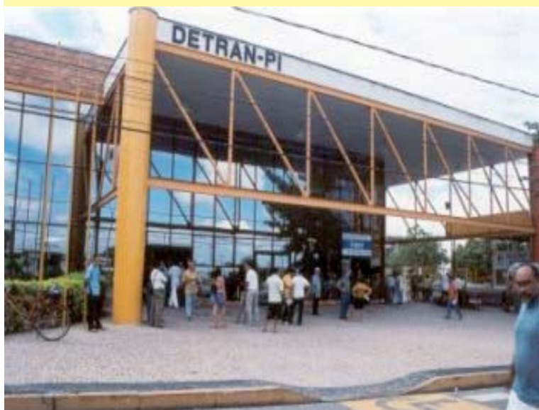
Sede do DETRAN-PI no Bairro Redenção, em Teresina
