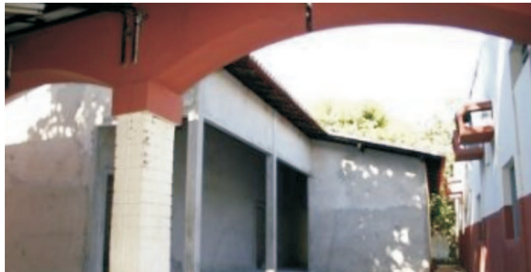
Reforma da Biblioteca do Campus
