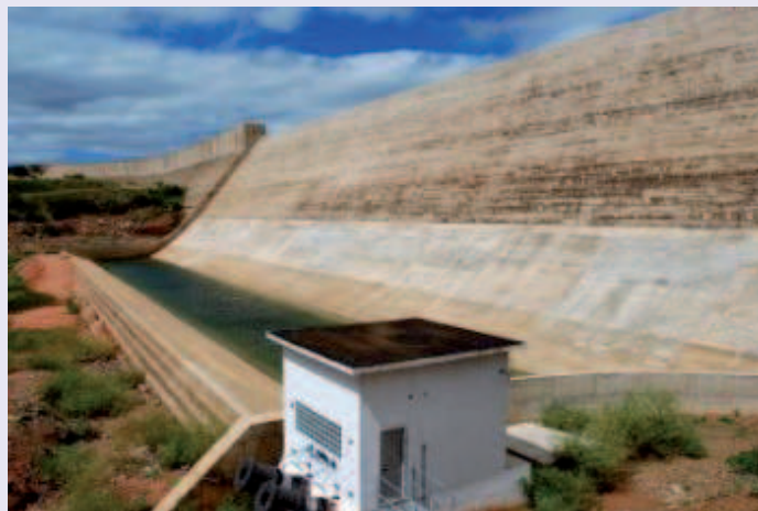
Barragem Poço Marruás
