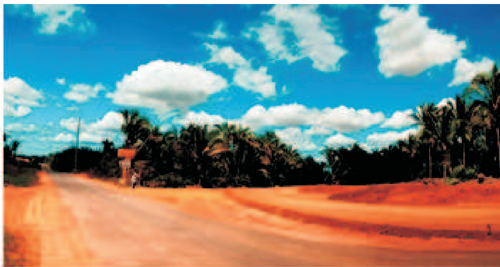
Acesso Sul da Ponte do Mocambinho
