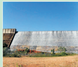
Obras da barragem de Atalaia
