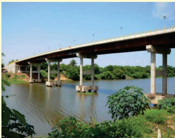
Ponte do Mocambinho (Foto:Francisco Leal)
