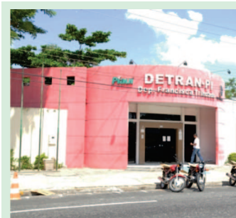
Posto Detran Francisca Trindade
