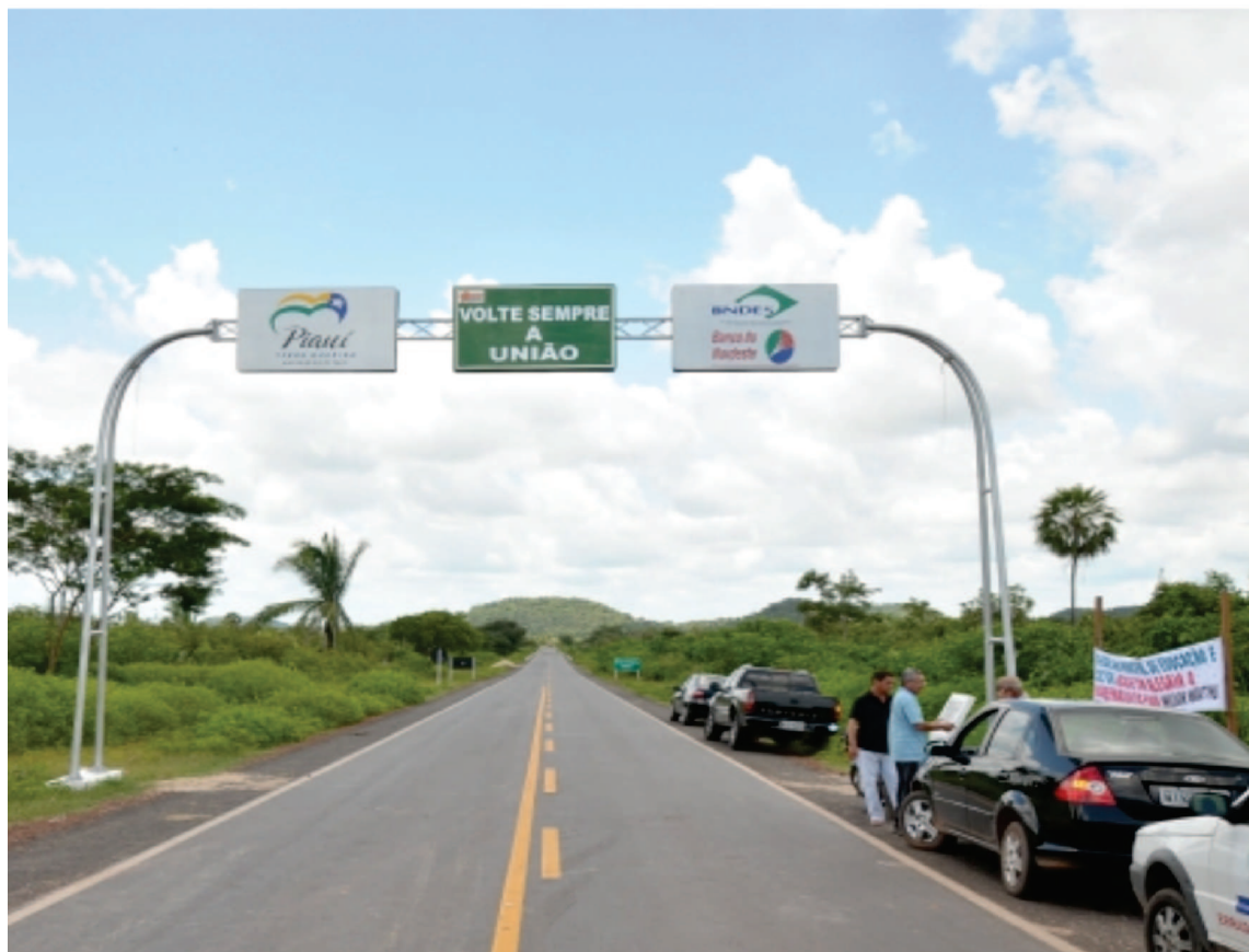
Entrega da pavimentação asfáltica da PI-112 em União (Foto:Kalberto Rodrigues)
