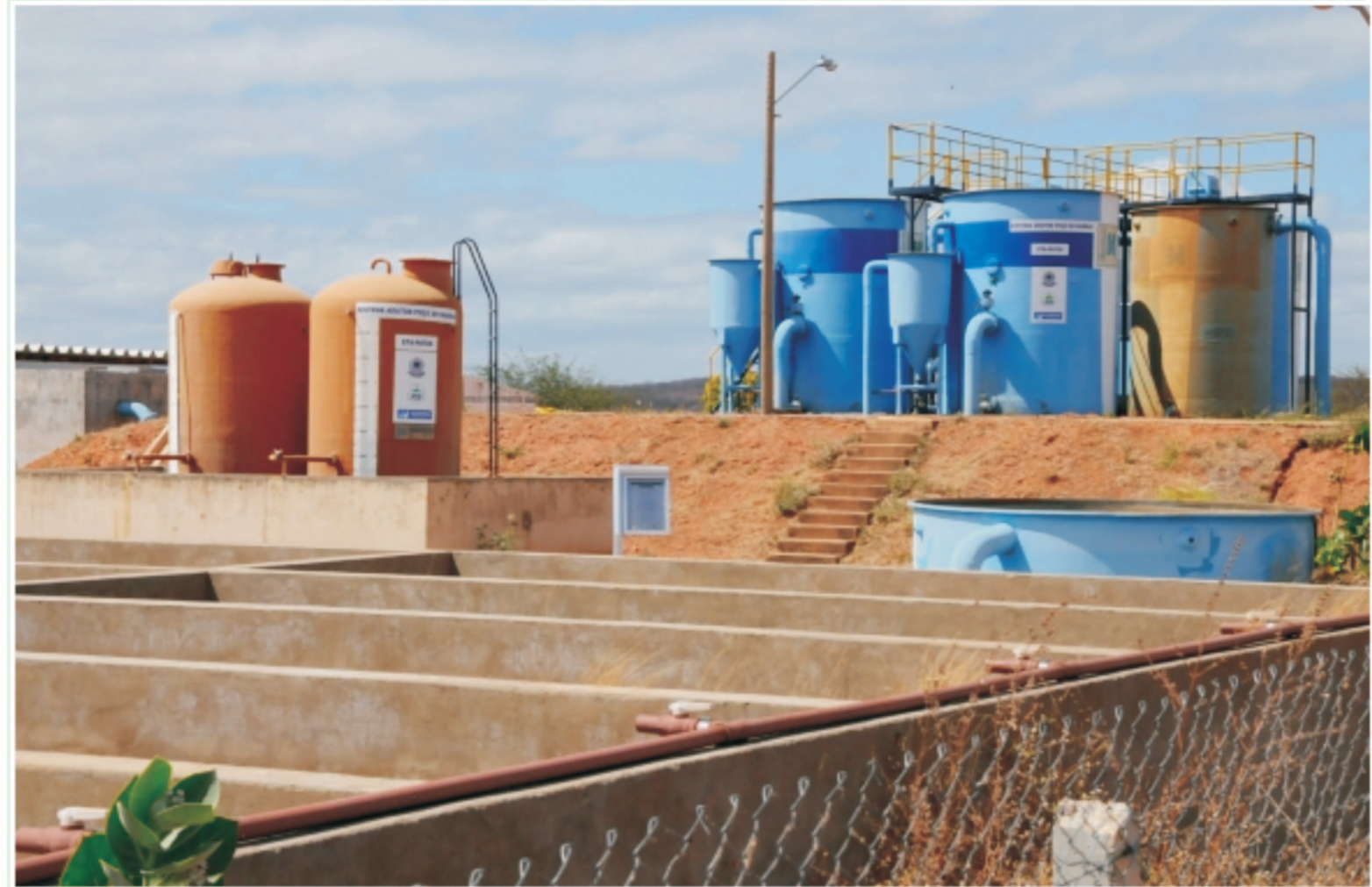
Adutora da Barragem no Sul do Piauí (Foto:Francisco Leal)
