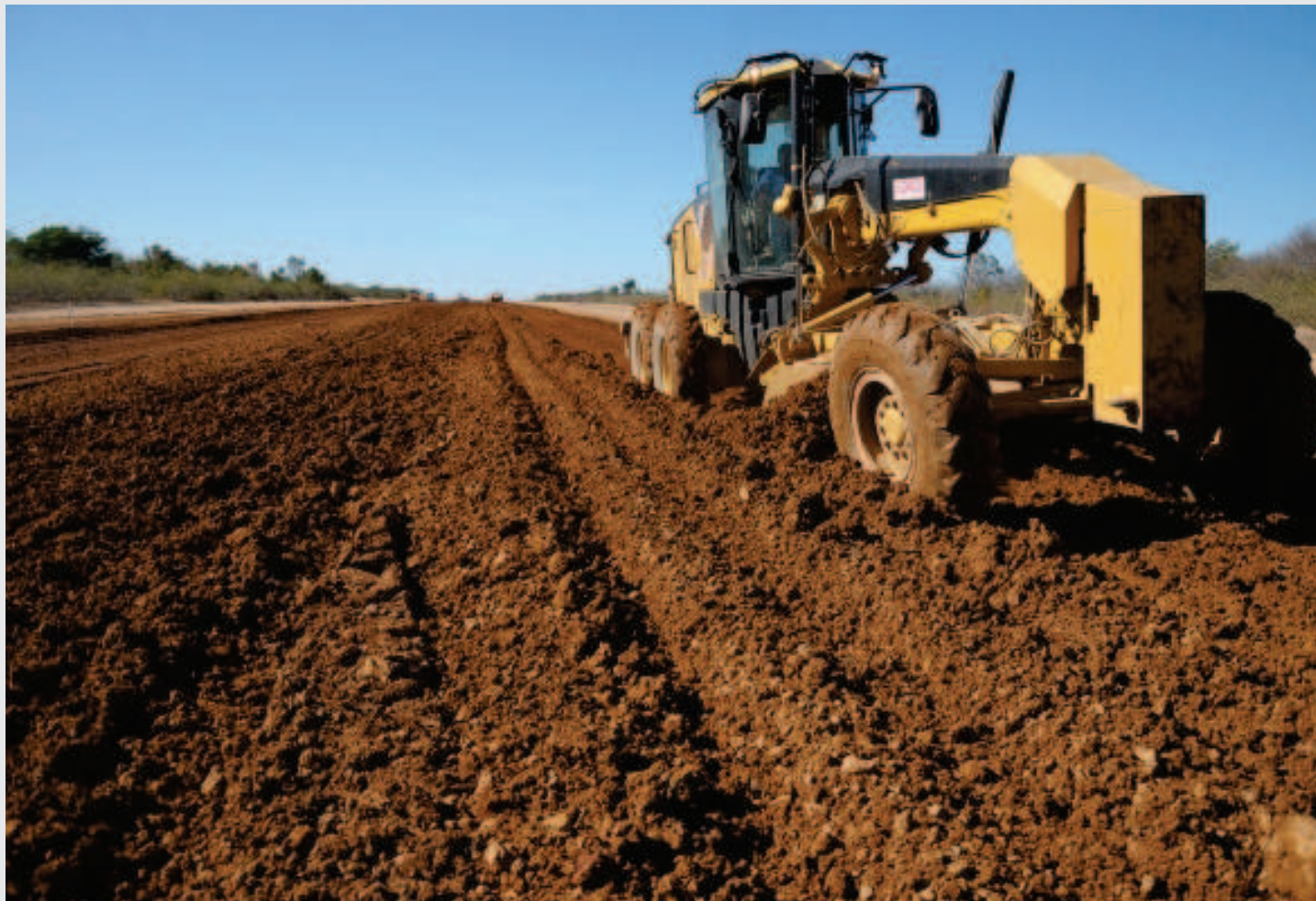
Obras do aeroporto de Floriano (Foto:Francisco Leal)
