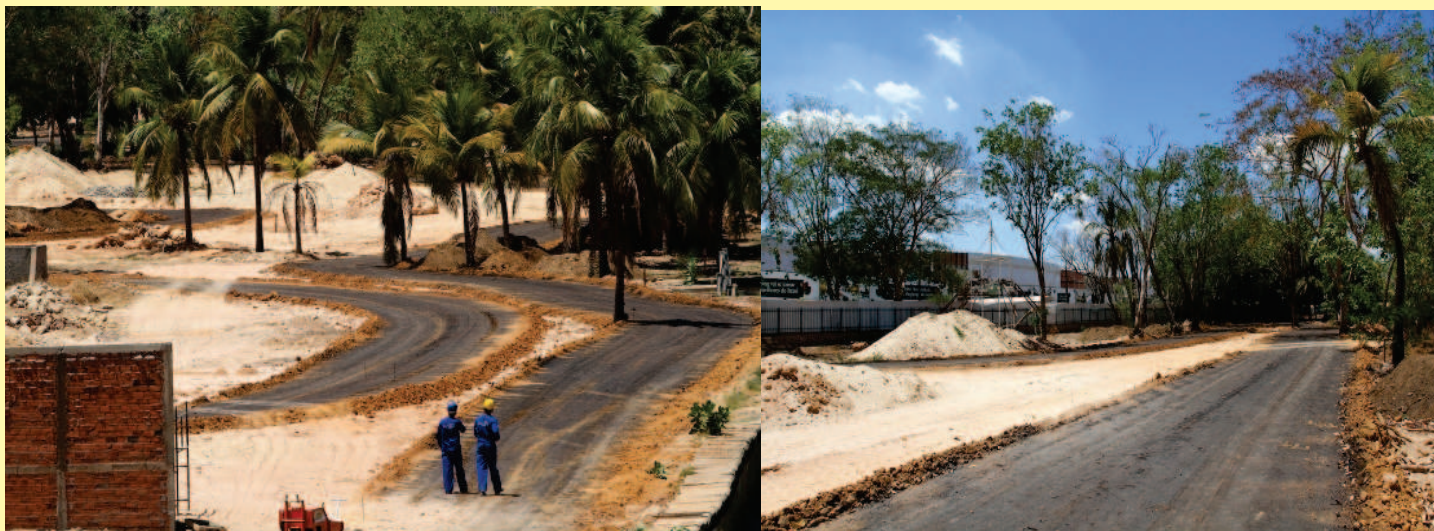
Obras no Parque Potycabana(Foto: Thiago Amaral)
