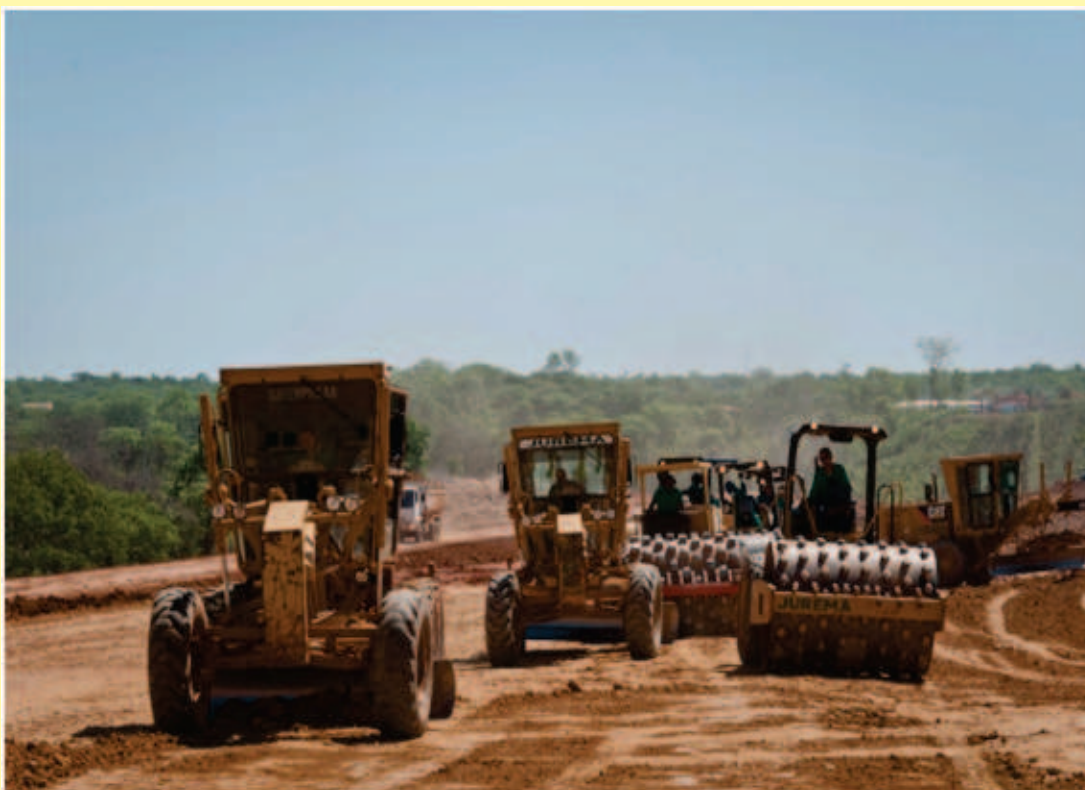
Obras na barragem Atalaia, em Sebastião Barros (Foto:Regis Falcão)
