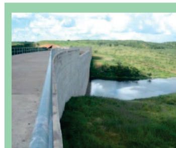
Projetos de recuperação e construção de barragens
