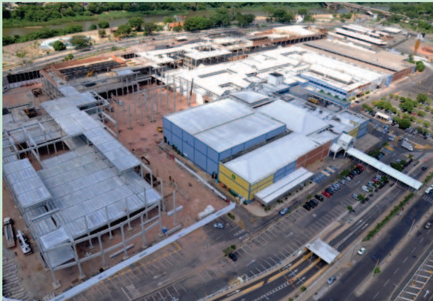
Construção civil (Foto: Paulo Barros)
