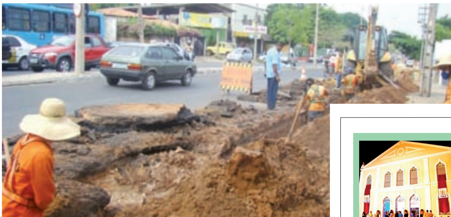
Obras executadas pela Agespisa (Foto:Ascom Agespisa)
