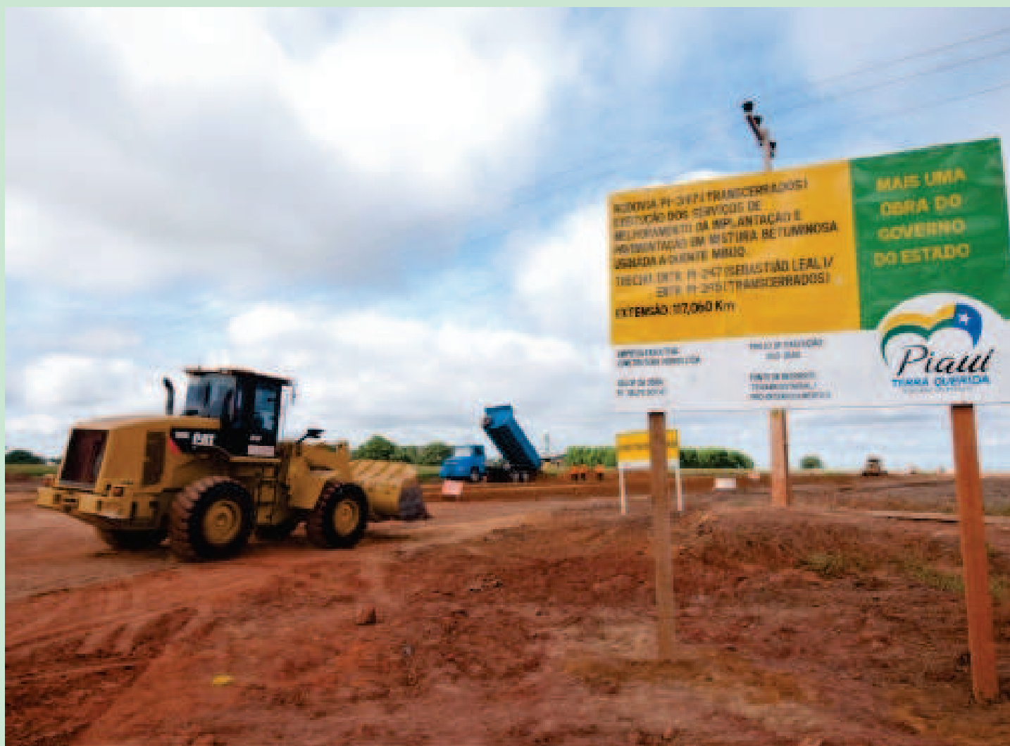
Em maio deste ano foram iniciadas as obras da Transcerrados (Foto:Regis Falcão)
