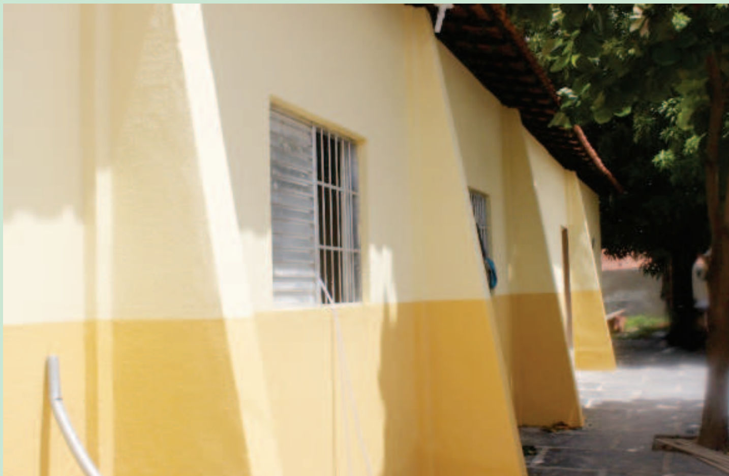
Obras de reforma do CSU do bairro Matadouro (Foto:Ascom Seinfra)
