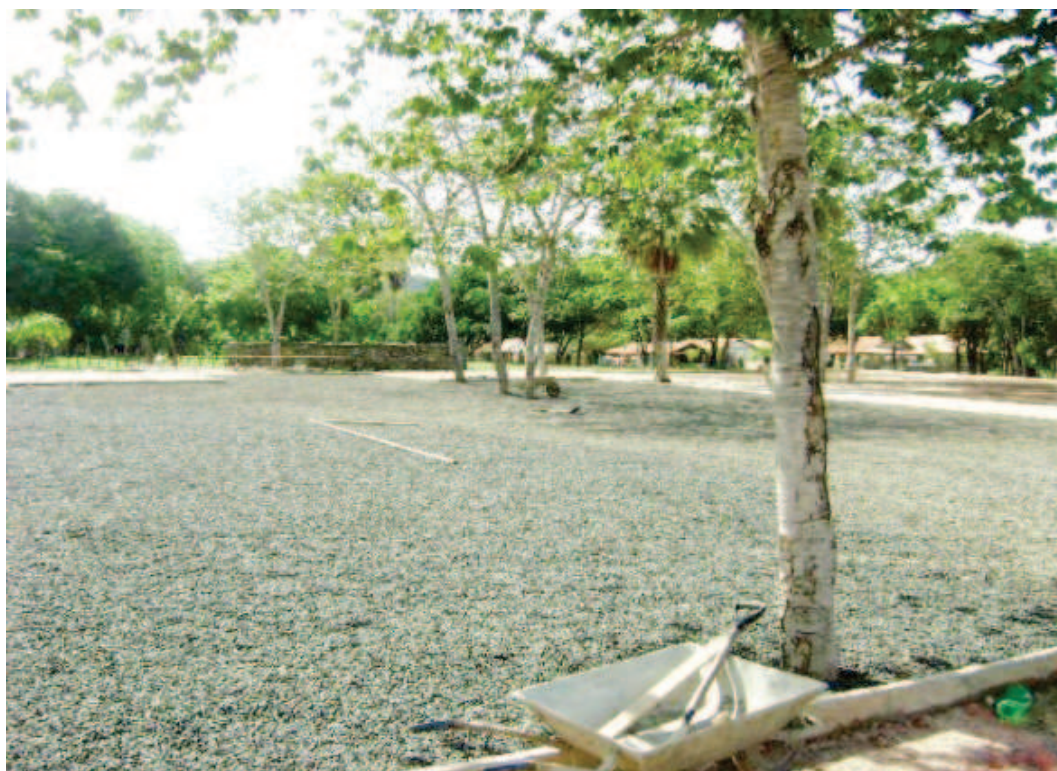
Obra de urbanização da Gruta Betânia (Foto:Seinfra)
