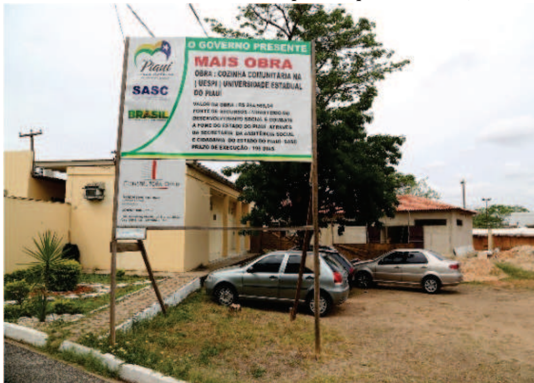
Obras da cozinha comunitária está em fase de finalização (Foto:Thiago Amaral)
