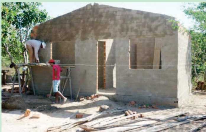
Construção de moradias rurais (Foto:Ascom ADH)
