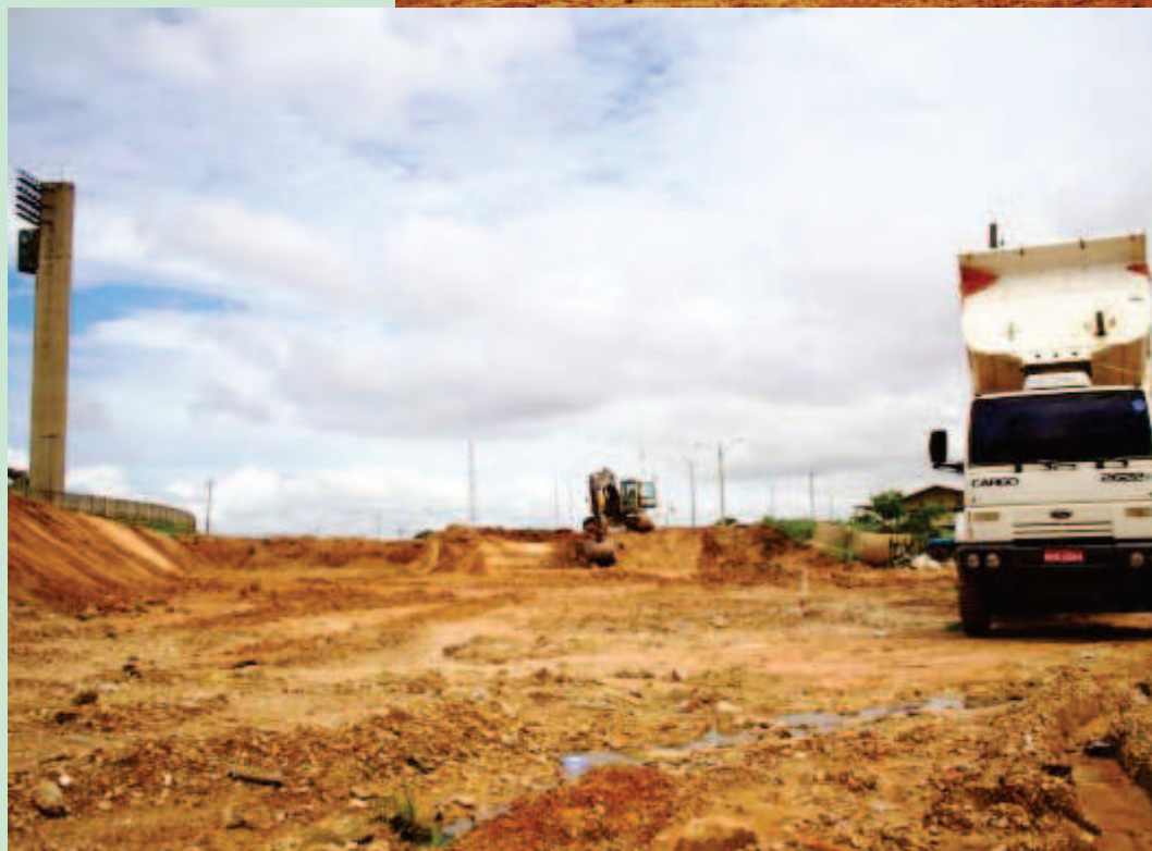
Obras do prolongamento da Av. Barão de Castelo Branco (Foto:Igor Prado)
