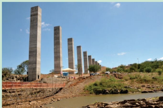
Obras da Ferrovia Transnordestina (Foto:Francisco Leal)
