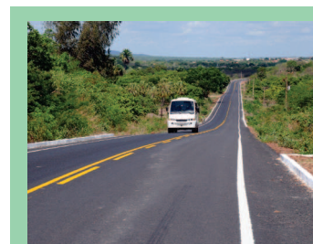
Obras e benefícios em diversos municípios
