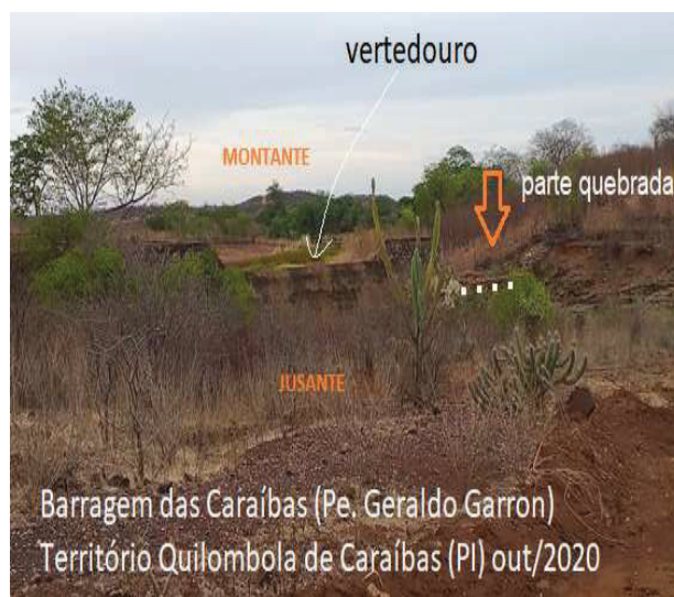
Fotografia 58 – Eixo quebrado da Barragem das Caraíbas desde 18 de fevereiro de 2004
