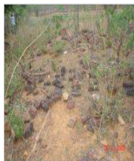
Foto 18 – Visão geral de parte da construção caída
